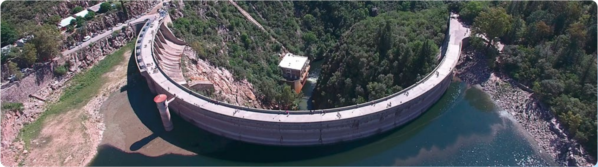
Central Hidroeléctrica La Viña
