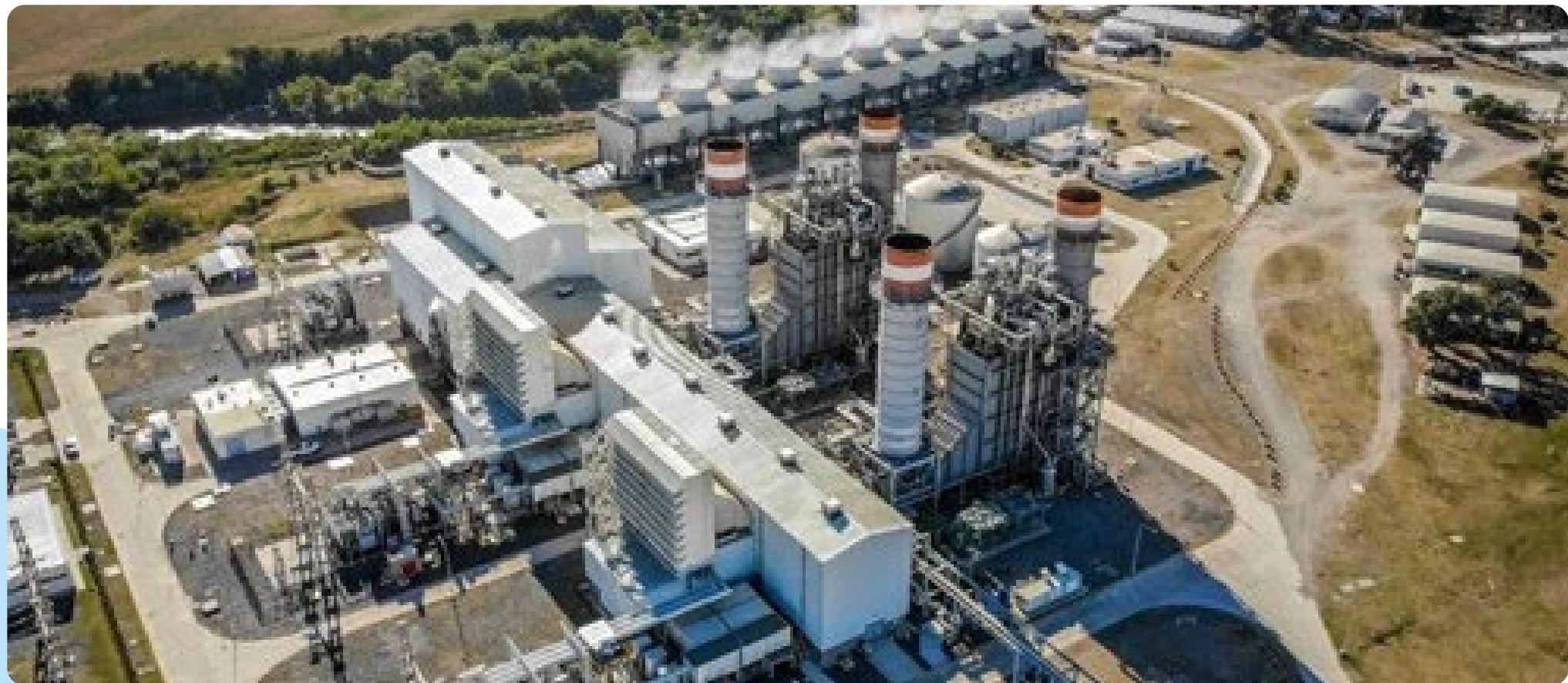
Central Termica de Ciclo Combinado “Bicentenario”
